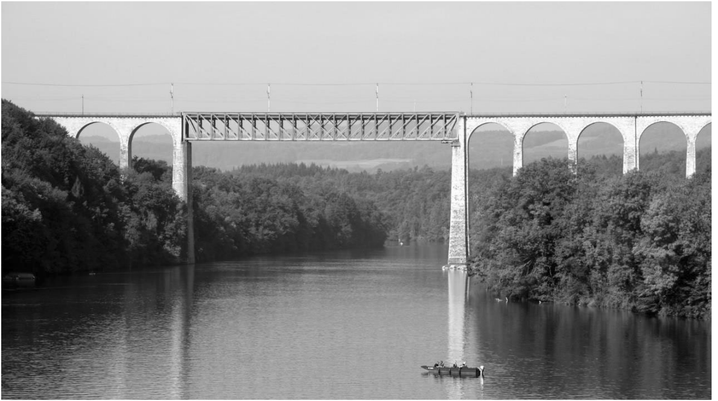
Rheinbrücke Eglisau, Buss&Cie (1897) Photos © SBB
