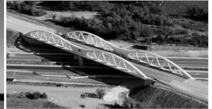
HS Riudellots de la Selva Viaduct, Spain, 2009. Fhecor Ingenieros
