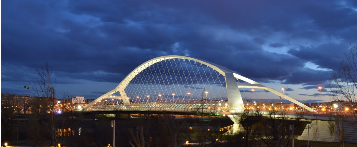
Puente del Tercer Milenio, Zaragoza (2008)
