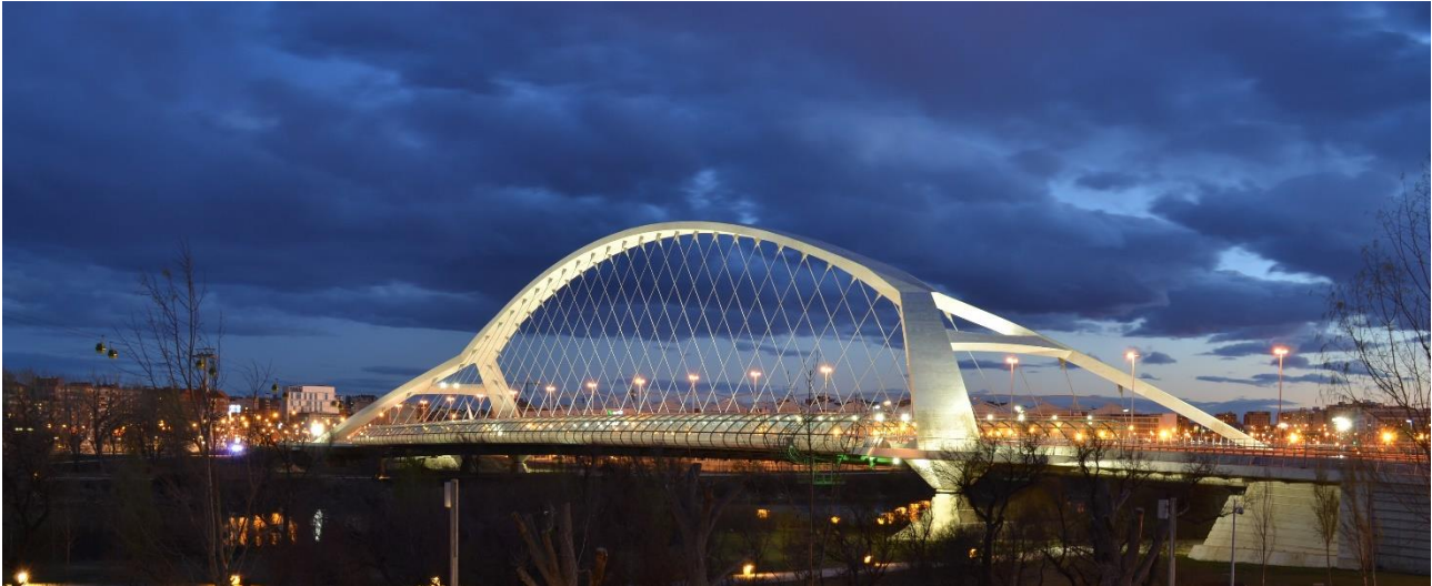
Puente del Tercer Milenio, Zaragoza (2008)
