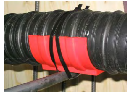
Bild 5: Spanngliedunterstützung mit Schutzschale
