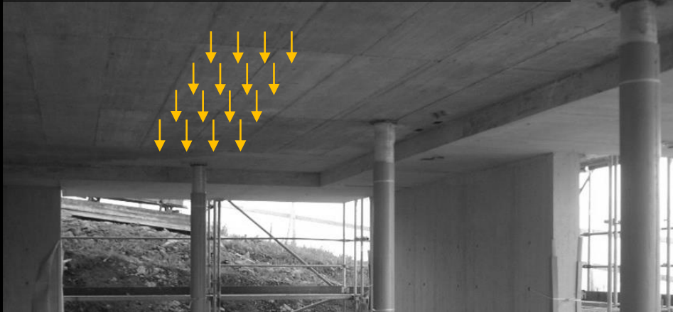
Platten primär senkrecht zur Ebene belastet
