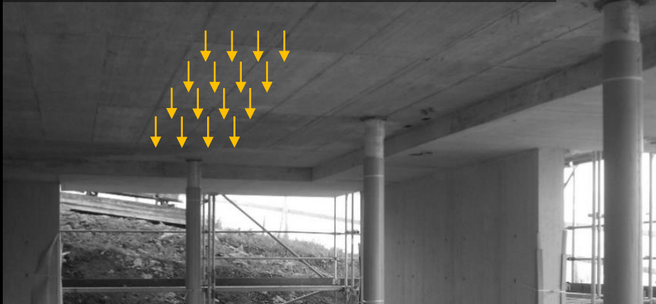
Platten primär senkrecht zur Ebene belastet
