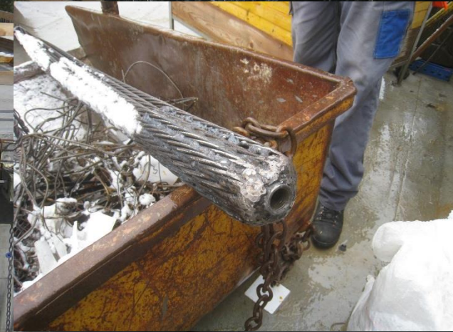
Kontinuitätskabel L = 240 m Sonderlösung (einziehen ganzes Bündel mit Winde)
