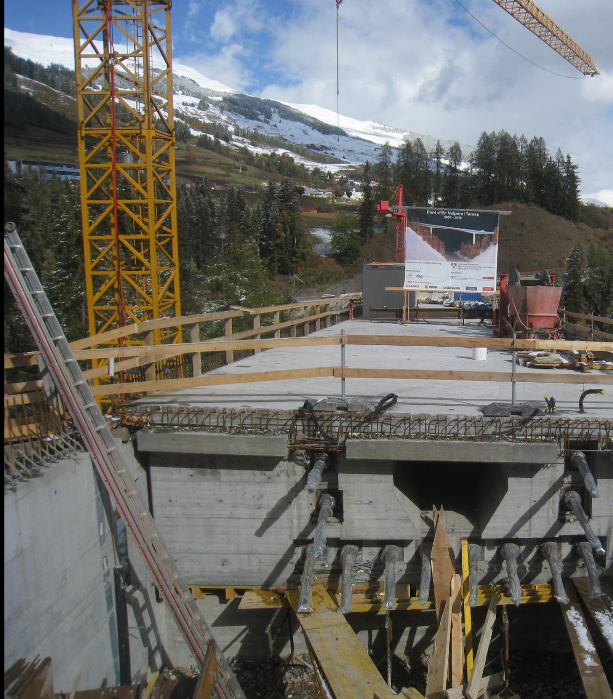
Kontinuitätskabel L = 240 m Sonderlösung (einziehen ganzes Bündel mit Winde)
