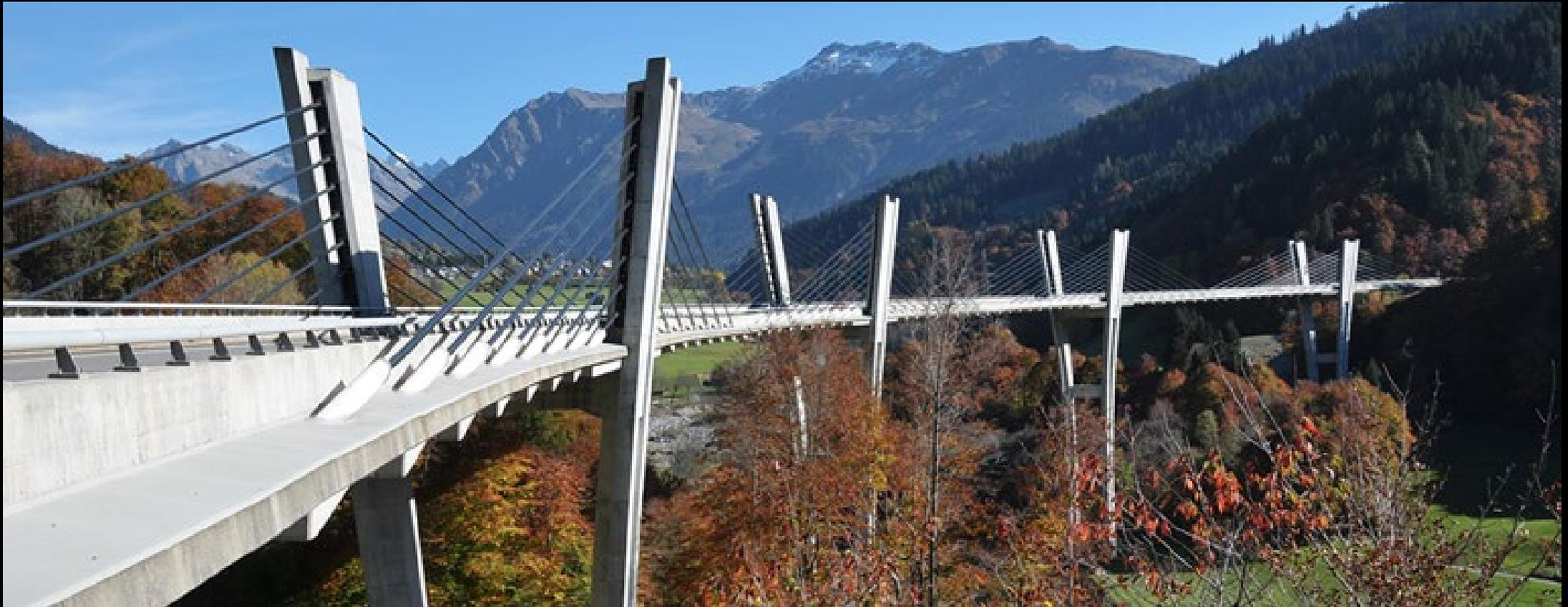
Die von Prof. Ch. Menn entworfene Sunnibergbrücke war eine der weltweit ersten Schrägseilbrücken mit sehr flachen Kabeln. Solche «Cable Stayed Bridges» mit steifem Überbau und flachen Kabeln werden international oft als «Extradosed Bridges» bezeichnet. Die Unterscheidung macht höchstens dann Sinn, wenn die Schrägseile bei der Bemessung ähnlich wie externe Vorspannkabel behandelt werden (höhere Ausnutzung zulässig, dafür konservativere Lastkombinationen zu berücksichtigen).
