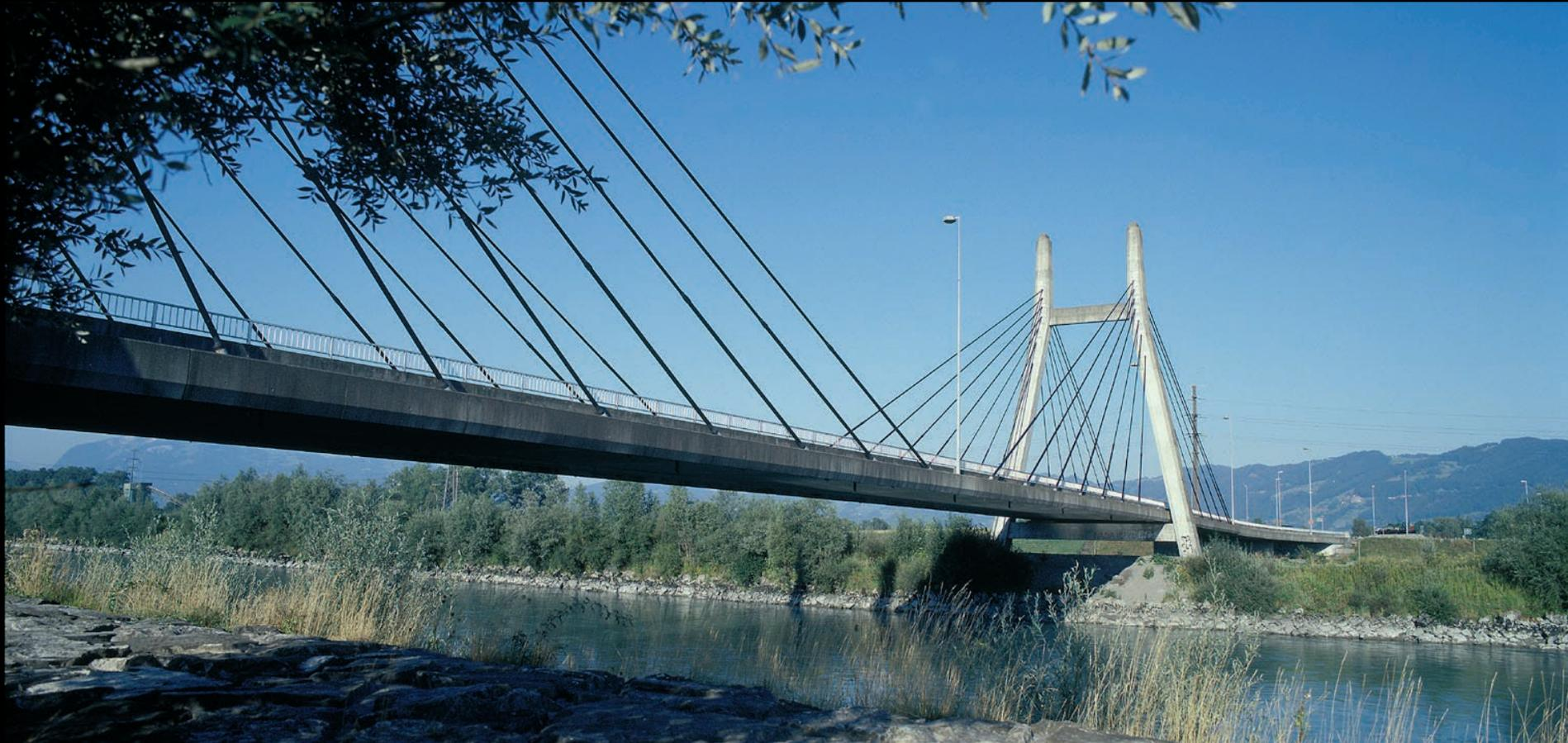
Bei der Rheinbrücke Diepoldsau wurde erstmals ein von Prof. René Walther entwickeltes Konzept umgesetzt, das einen schlanken Versteifungsträger in Kombination mit einer grossen Anzahl von Schrägkabeln kombiniert. Diese elegante Lösung ermöglicht eine effiziente Bauausführung eines Betonüberbaus im Freivorbau und wurde weltweit bei sehr vielen Brücken eingesetzt.
