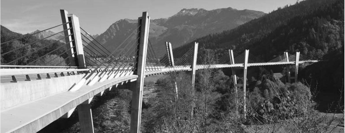
Die von Prof. Ch. Menn entworfene Sunnibergbrücke war eine der weltweit ersten Schrägseilbrücken mit sehr flachen Kabeln. Solche «Cable Stayed Bridges» mit steifem Überbau und flachen Kabeln werden international oft als «Extradosed Bridges» bezeichnet. Die Unterscheidung macht höchstens dann Sinn, wenn die Schrägseile bei der Bemessung ähnlich wie externe Vorspannkabel behandelt werden (höhere Ausnützung zulässig, dafür konservativere Lastkombinationen zu berücksichtigen).
