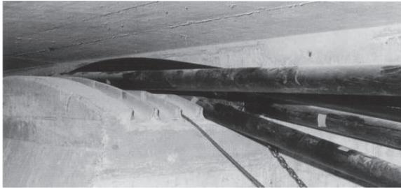
Bei einer externen Vorspannung verlaufen die Kabel abschnittsweise gerade. An den Umlenkpunkten sind relativ aufwändige Konstruktionen (Umlenksättel) erforderlich, da grosse Ablenkkräfte auftreten und eine kontinuierliche Umlenkung der Kabel gewährleistet werden muss. Knicke, insbesondere an den Enden der Umlenksättel (wenn diese zu kurz sind), sind unter allen Umständen zu vermeiden, da sonst die Spannglieder beschädigt werden.
