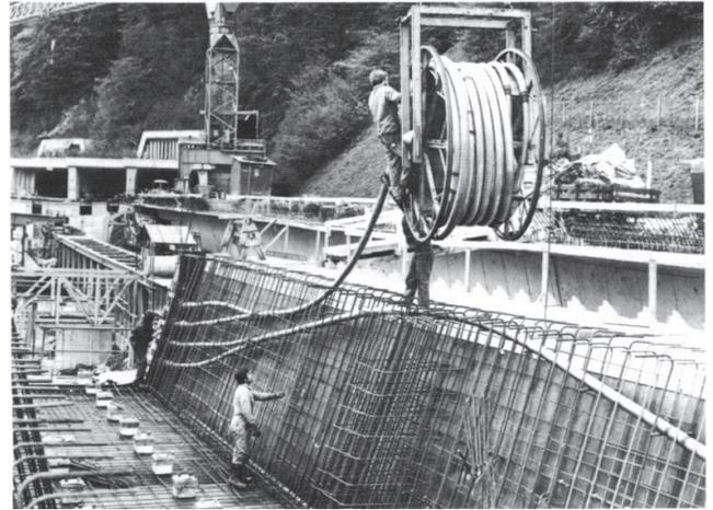
Früher wurden die Spannglieder meist vorkonfektioniert (Spannstahl, Hüllrohr und Anker) und auf sogenannten Bobinen auf die Baustelle geliefert. Bei einer Vorspannung mit Drähten, die über aufgestauchte Enden verankert werden (System Stahlton) wird dies noch heute gemacht.
