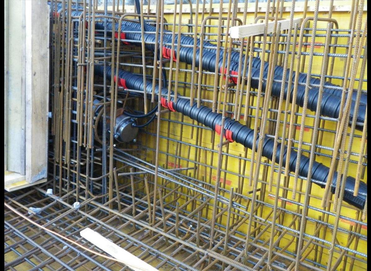
Vorspannung – Fester Anker mit Injektionsanschluss, Kunststoffhüllrohre mit Kabelhaltern und Halbschalen zur Vermeidung von Knicken
