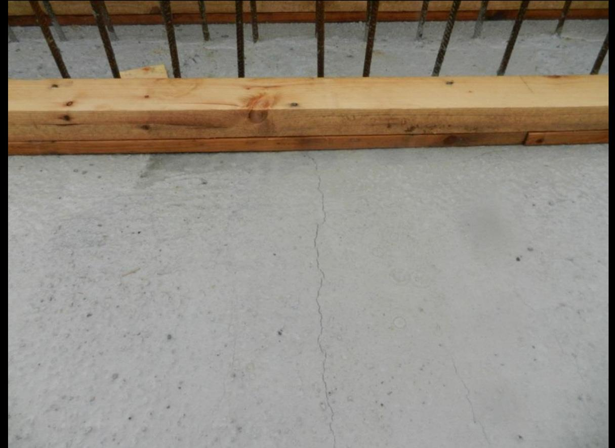
Aber: Minimieren der Rissbreiten durch Mindestbewehrung, die konstruktiv richtig durchgebildet ist, zwängungsarme Ausbildung, gute Nachbehandlung etc.!
