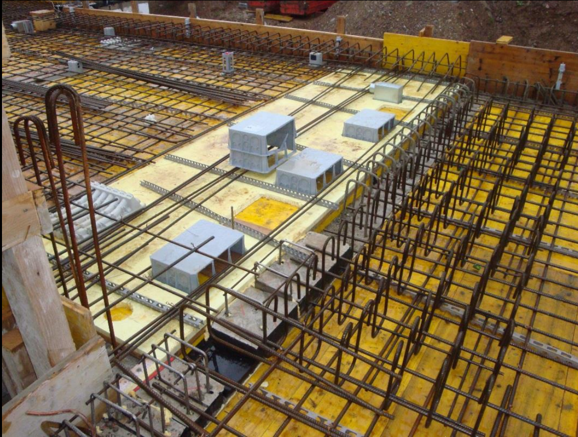
Deckenbewehrung - Kunststoffleisten für Einhaltung der Bewehrungsüberdeckung (nur im Hochbau)
