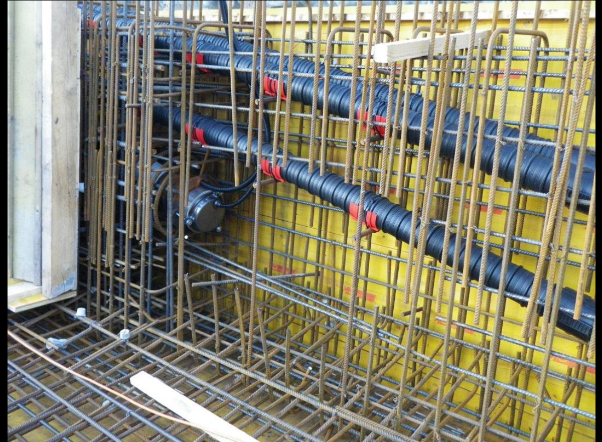
Vorspannung – Fester Anker mit Injektionsanschluss, Kunststoffhüllrohre mit Kabelhaltern und Halbschalen zur Vermeidung von Knicken Distanzklötze unter innerer Schalung
