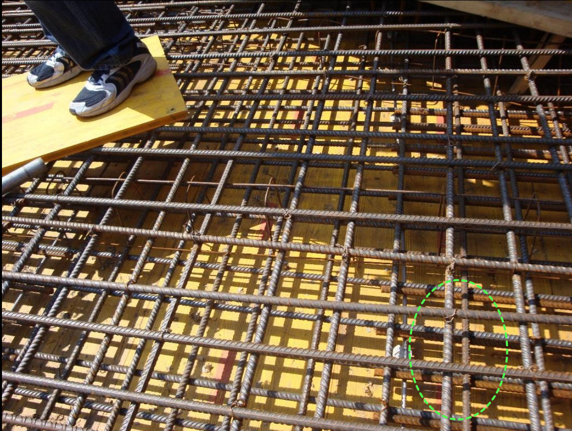
Bewehrung einer Brückenplatte – Zementklötze und «rostfreie» Bewehrung für Einhaltung der Bewehrungsüberdeckung
