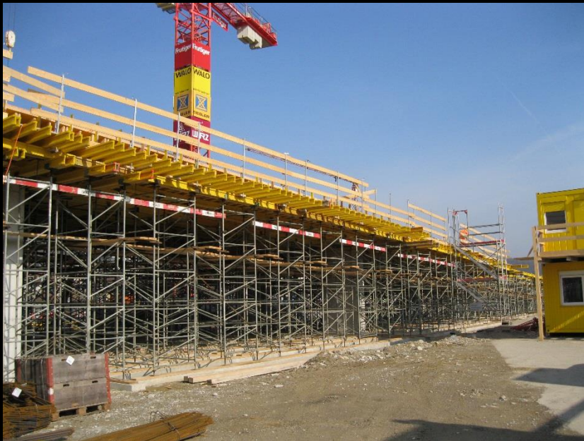
Konventionelles Lehrgerüst (Viadukt Wangen b.O.)
