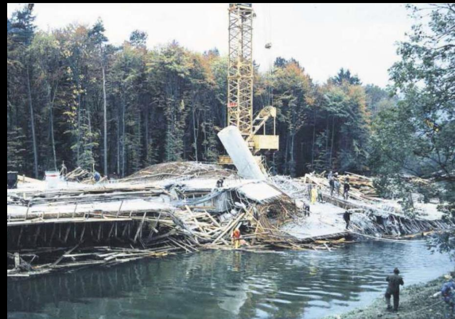
Lehrgerüsteinsturz 1966: Tössbrücke Winterthur
