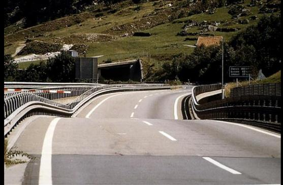
Bei moderaten Bewehrungsgehalten, Verwendung duktiler Bewehrung und sorgfältiger konstruktiver Durchbildung verhalten sich Stahlbeton- und Spannbetonträger sehr duktil. Dies wird auf den folgenden Folien anhand zweier Beispiele demonstriert.
