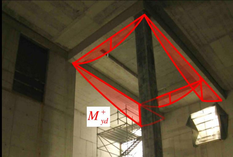
→ System von Einfeldträgern, mittiger Querträger auf zwei Längsträgern gelagert (vereinfacht als einfache Balken modelliert)
