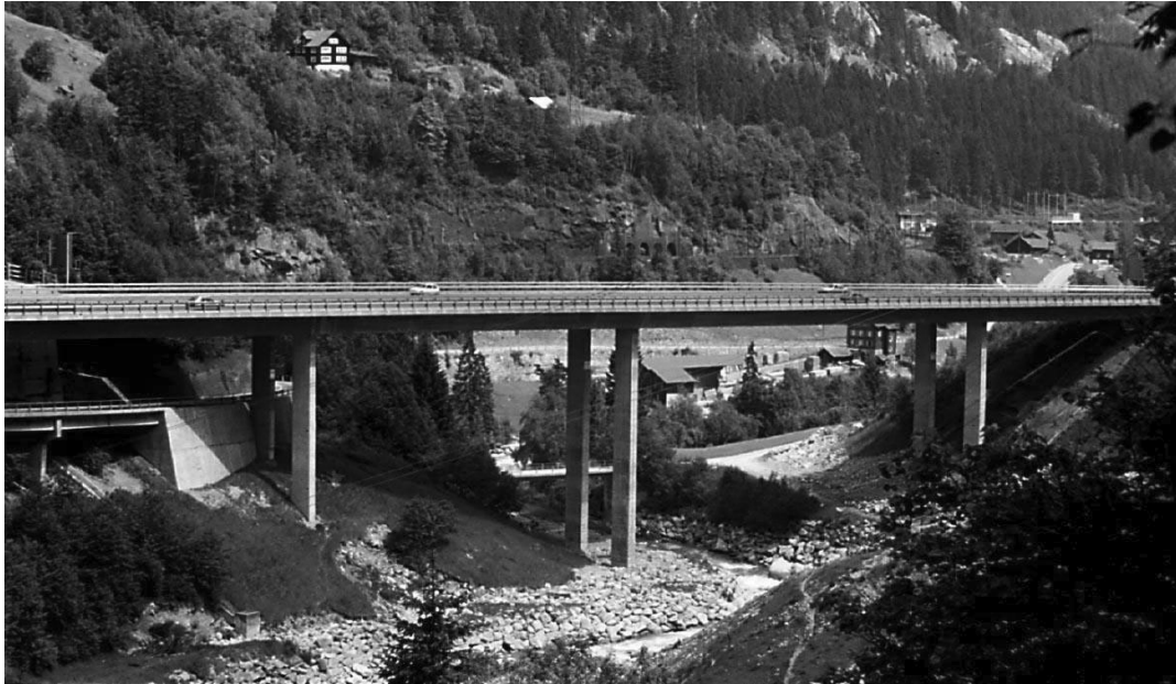
Reussbrücke Wassen (Baujahr 1972) im Juli 1987
