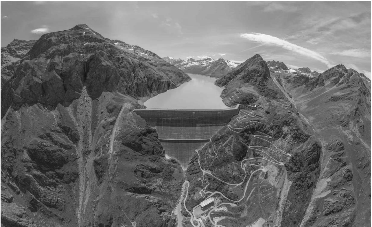
Staumauer Grande Dixence (1951-1965, Höhe 285 m)
