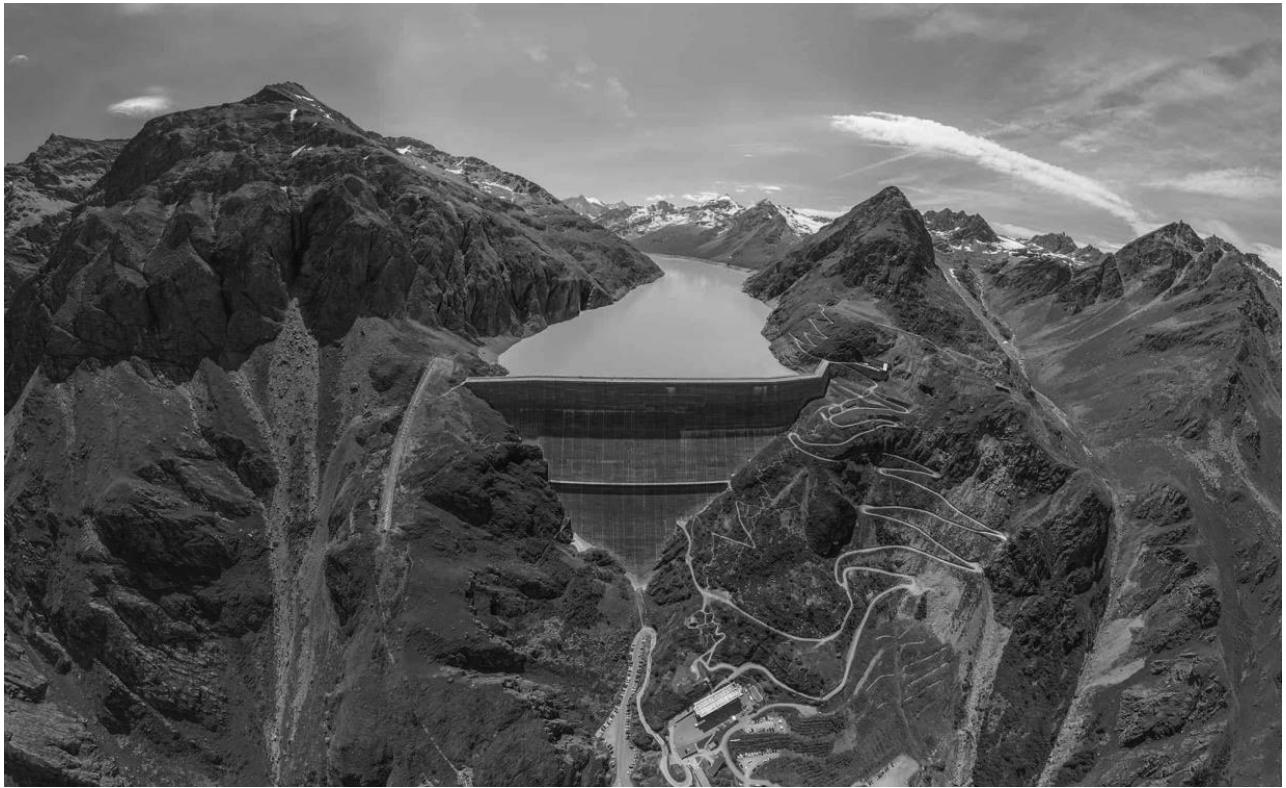
Staumauer Grande Dixence (1951-1965, Höhe 285 m)
