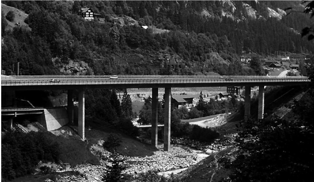
Reussbrücke Wassen (Baujahr 1972) im Juli 1987
