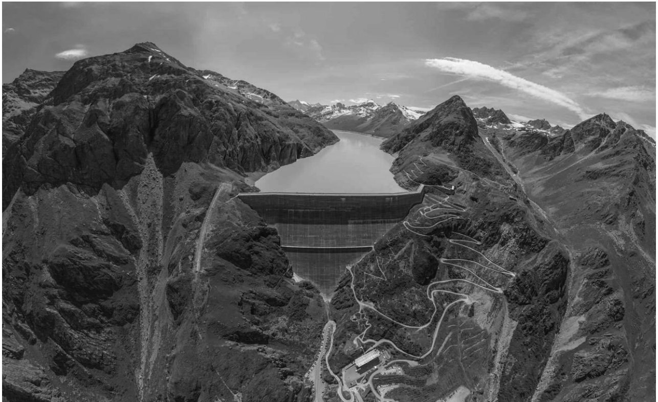
Staumauer Grande Dixence (1951-1965, Höhe 285 m)
