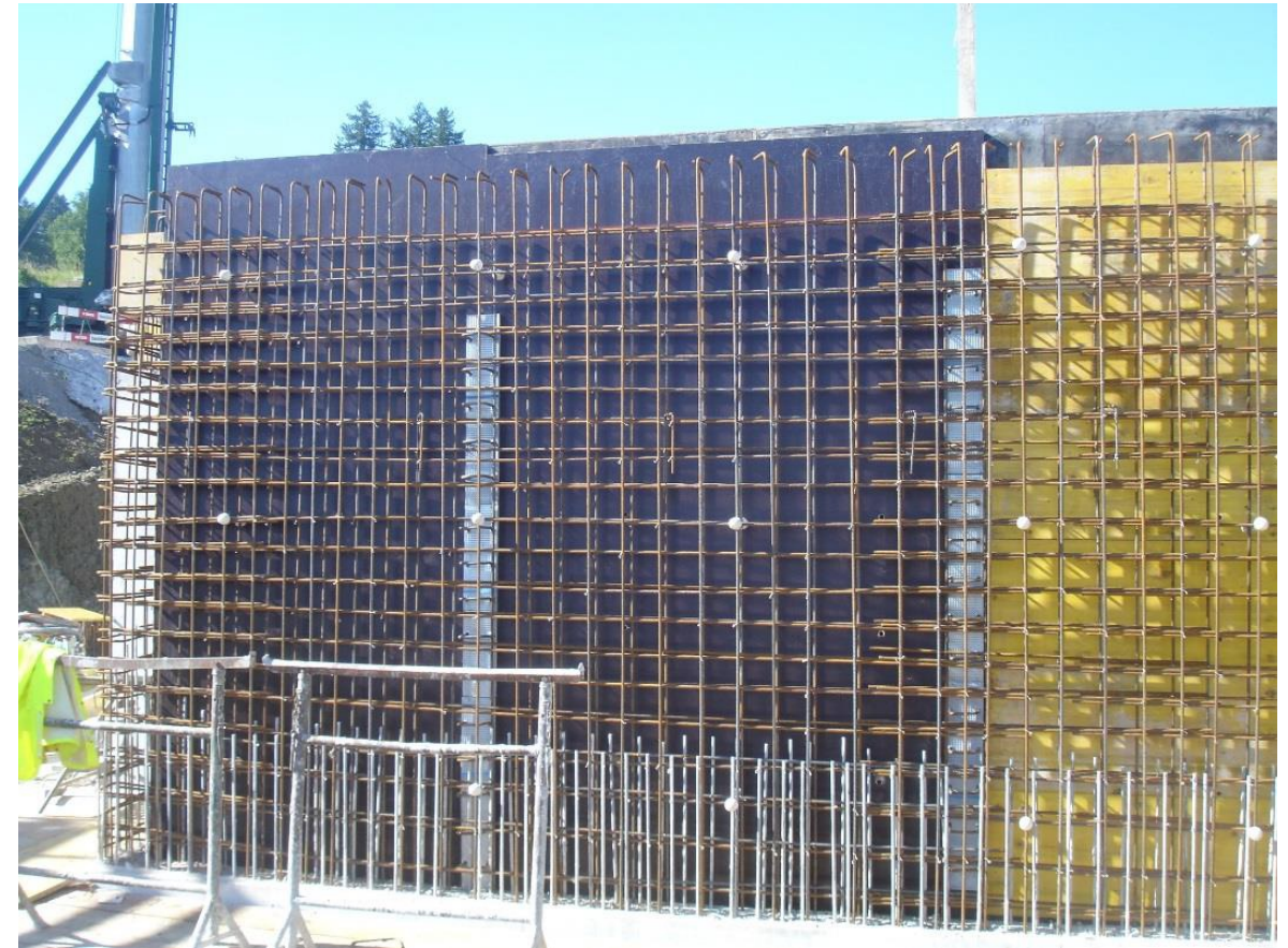
Wandbewehrung - Zementklötze für Einhaltung der Bewehrungsüberdeckung (Hoch- und Tiefbau)
