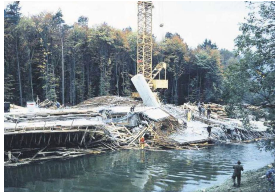
Lehrgerüsteinsturz 1966: Tössbrücke Winterthur
