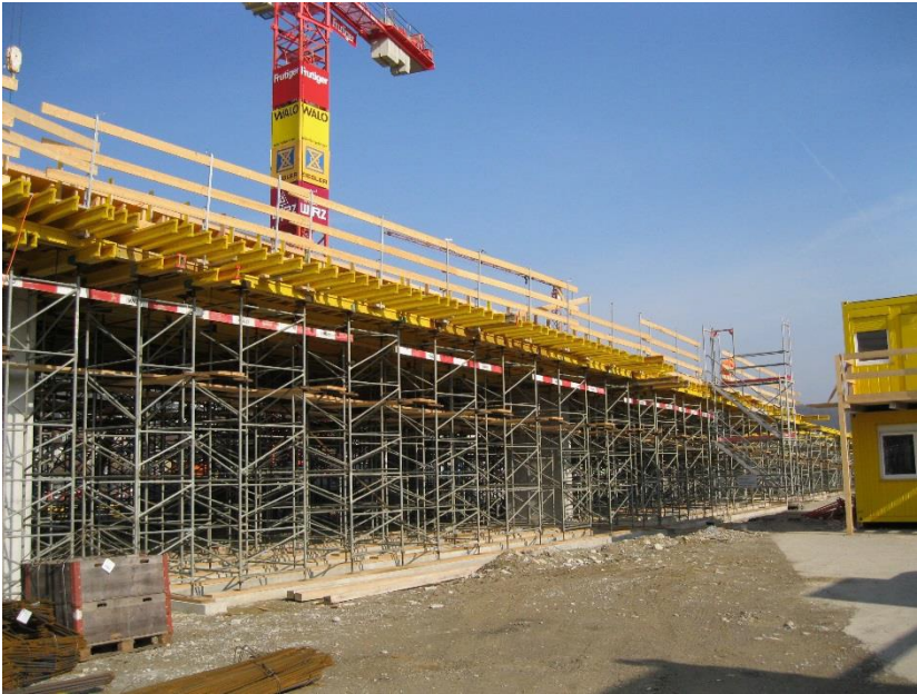
Konventionelles Lehrgerüst (Viadukt Wangen b.O.)
