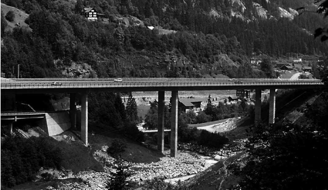
Reussbrücke Wassen (Baujahr 1972) im Juli 1987
