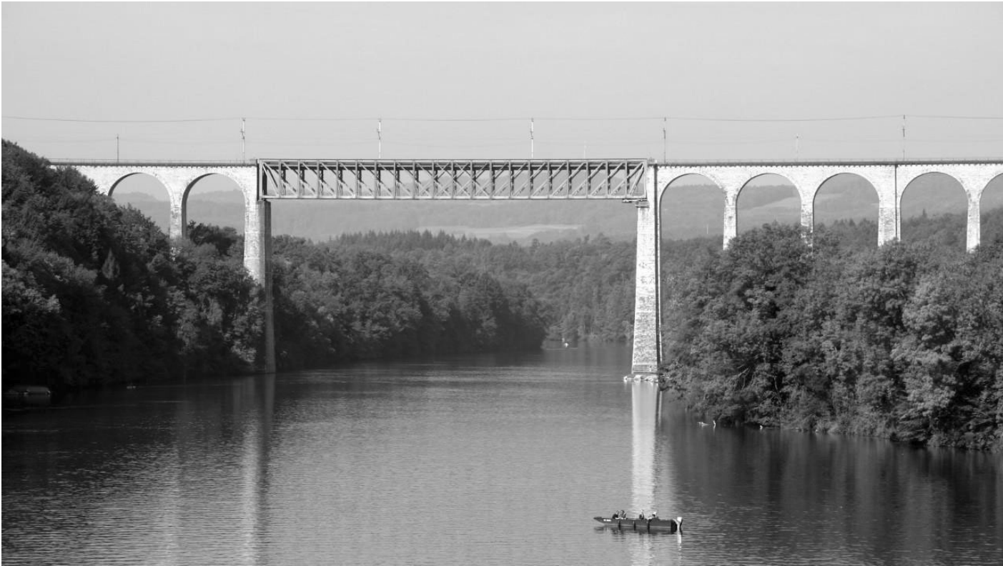
Rheinbrücke Eglisau, Buss&Cie (1897) Photos © SBB
