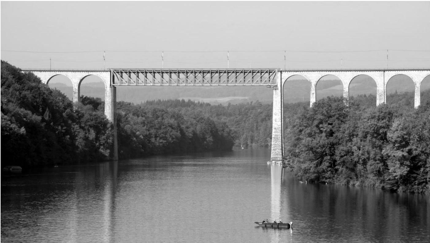
Rheinbrücke Eglisau, Buss&Cie (1897) Photos © SBB
