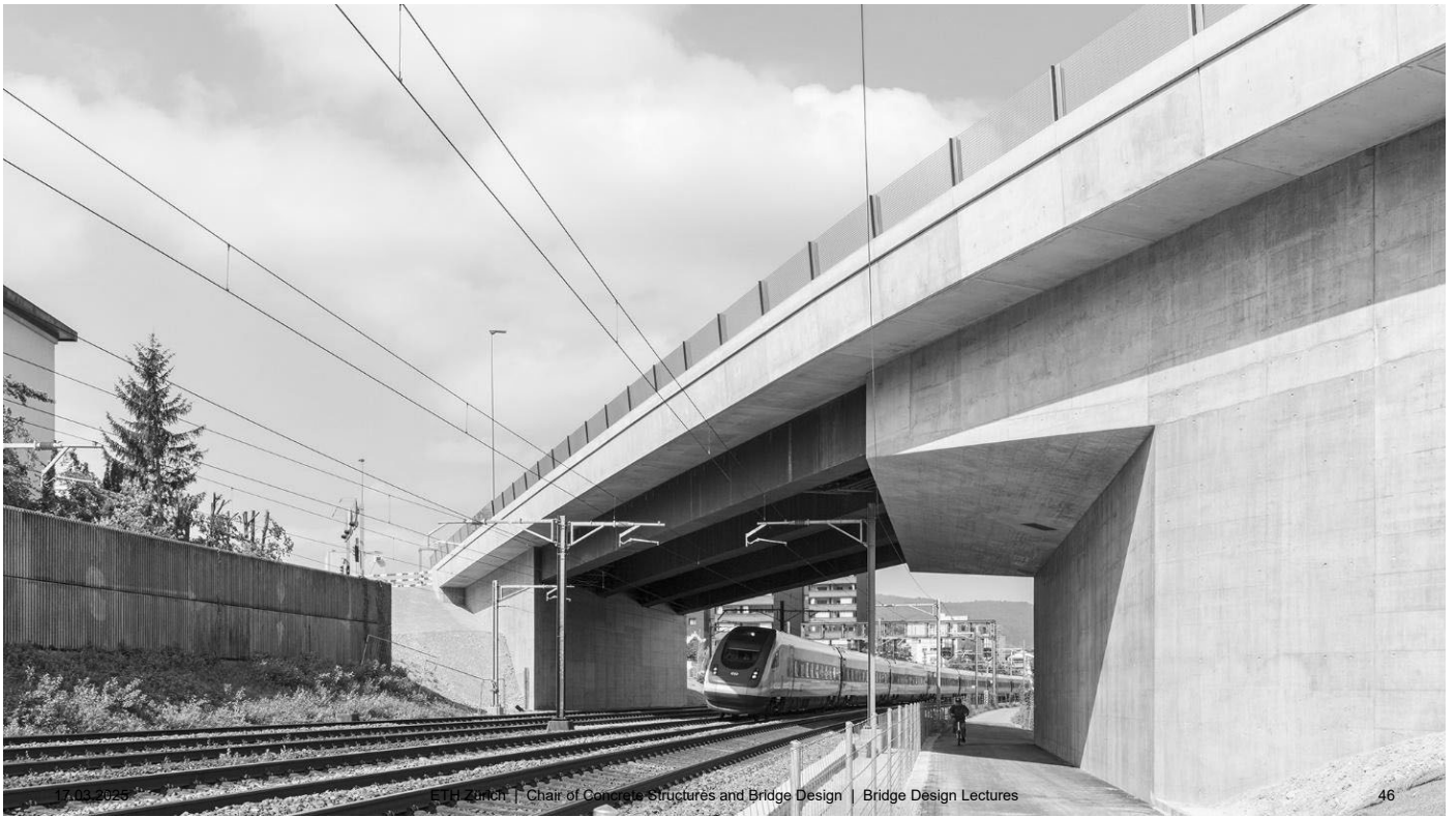
Brücke Schönenwerd © dsp Ingenieure + Planer AG
