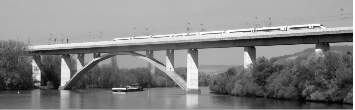
Veitshöchheim viaduct, Germany, 1986. ILF Beratende Ingenieure & Leonhardt, Andrä und Partner
