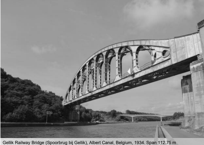
Gellik Railway Bridge (Spoorbrug bij Gellik), Albert Canal, Belgium, 1934. Span 112.75 m
