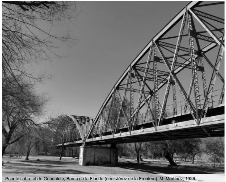
Puente sobre el río Guadalete, Barca de la Florida (near Jerez de la Frontera), M. Martínez, 1926.
