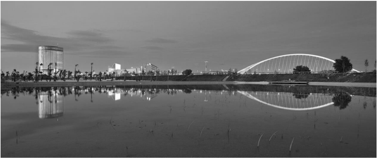
Project / Photos: Arenas & Asociados / Juan José Arenas de Pablo
