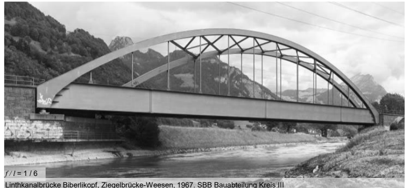
Linthkanalbrücke Biberlikopf, Ziegelbrücke-Weesen, 1967. SBB Bauabteilung Kreis III
